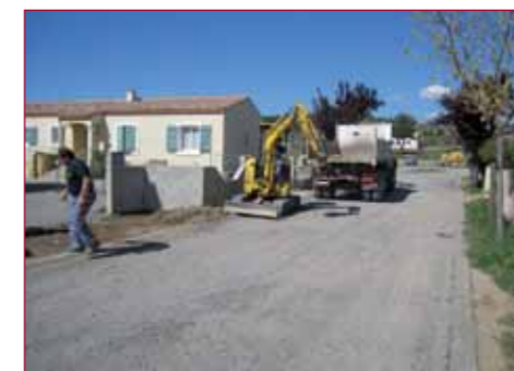
Voirie du lotissement Régus
