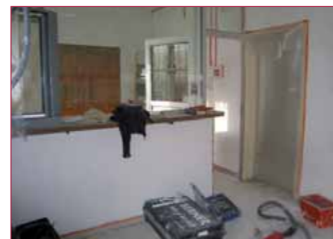
L'agence Postale rénovée
