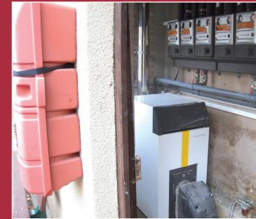
Feue la chaudière de 1965! Elle consommait plus de 9000 litres de fuel par an avec un coût de 6000€ pour chauffer tout le bâtiment de la mairie et ne permettait pas de gérer correctement les températures. Une chaudière Basse consommation a été installée et la gestion du chauffage a été optimisée. Elle chauffera aussi la maternelle. L'économie de fuel et d'électricité couvrira l'emprunt réalisé pour ces travaux. L'investissement de 35 000 € a été subventionné à 40% par Hérault Energie.
